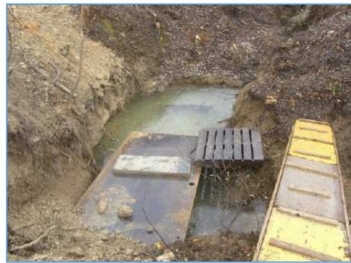
レイタンス処理・CON打設前の型枠内清掃、打設後の湿潤養生に使用するハイウォッシャーの水が確保が必要になった。本堤上流の小川に、高さ2.1m、幅1.5m、延長2.0mの鋼矢板を置き2枚の鉄板を立てその上にもう1枚水平に鉄板を敷き、ハイウォッシャーの水源確保と設置台を作成した。
