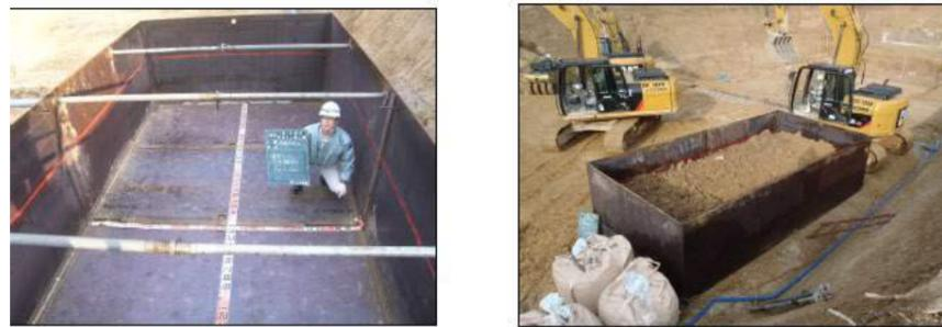
攪拌ピット寸法 母材投入 16.0m<sup>3</sup>
