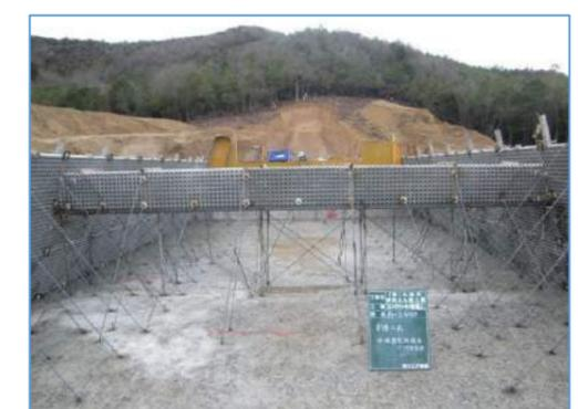
本堤・副堤の残存型枠施工の前にアングル(50×50)を型枠組立位置に水平に設置することにより製品の1枚ごとの段ちをなくし、高さ調整をしなくてもよくした。また型枠の位置ずれ防止、型枠1枚目足元のハラミ防止にもなった。水抜き部の床の代りにもなり残存型枠を浮かした状態で施工が可能になった。
