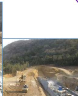
流用土で埋戻したが、軟弱土のためラフタークレーンの設置及び、生コン車の進入等ができないために、セメント固化材20t使用し地盤改良を行い作業ヤードを確保した。
