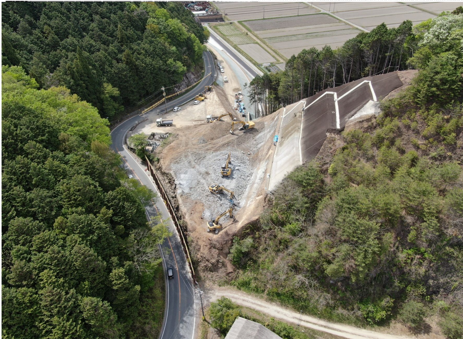
道路改築事業が進む「一般県道稲畑柏原線」(手前柏原側、上が稲畑側)。令和4年度を目標に峠部の線形不良、急勾配区間の解消が図られている
